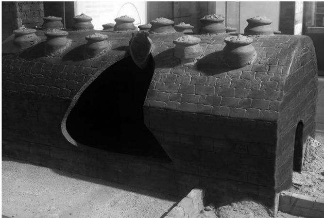
*El horno de jabeca consiste en un cuerpo hueco, en cuya bóveda hay una serie de huecos para colocar vasijas de cerámica (jabecas) con trozos de mineral con cinabrio en su interior. Con el calor, el azogue queda encima y, tras enfriar el horno, se puede separar de la ganga fácilmente.*
