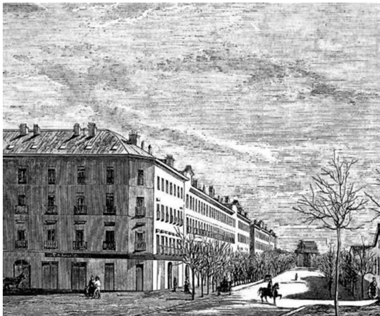
Construcciones en el Barrio de Salamanca
