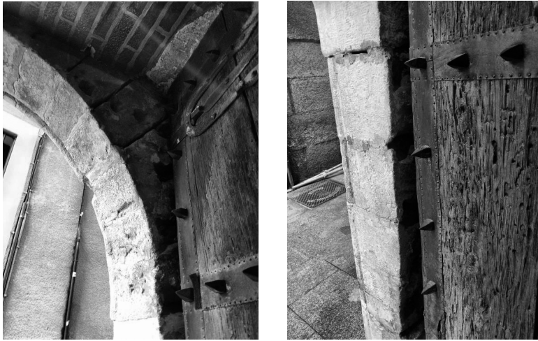
Figuras 9 y 10. Perforaciones realizadas a lo largo de todo el contorno de la portada de piedra, en su cara interior.
