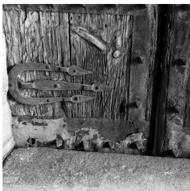
Figuras 15, 16, 17 y 18. Detalles del importante deterioro actual de la portada de piedra y las hojas de madera.
