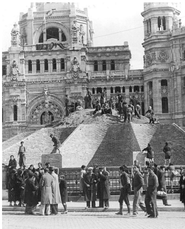
Protección de la fuente de Cibeles. Madrid
