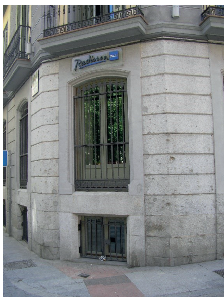
Huellas de metralla en la calle del Almendro. Madrid
